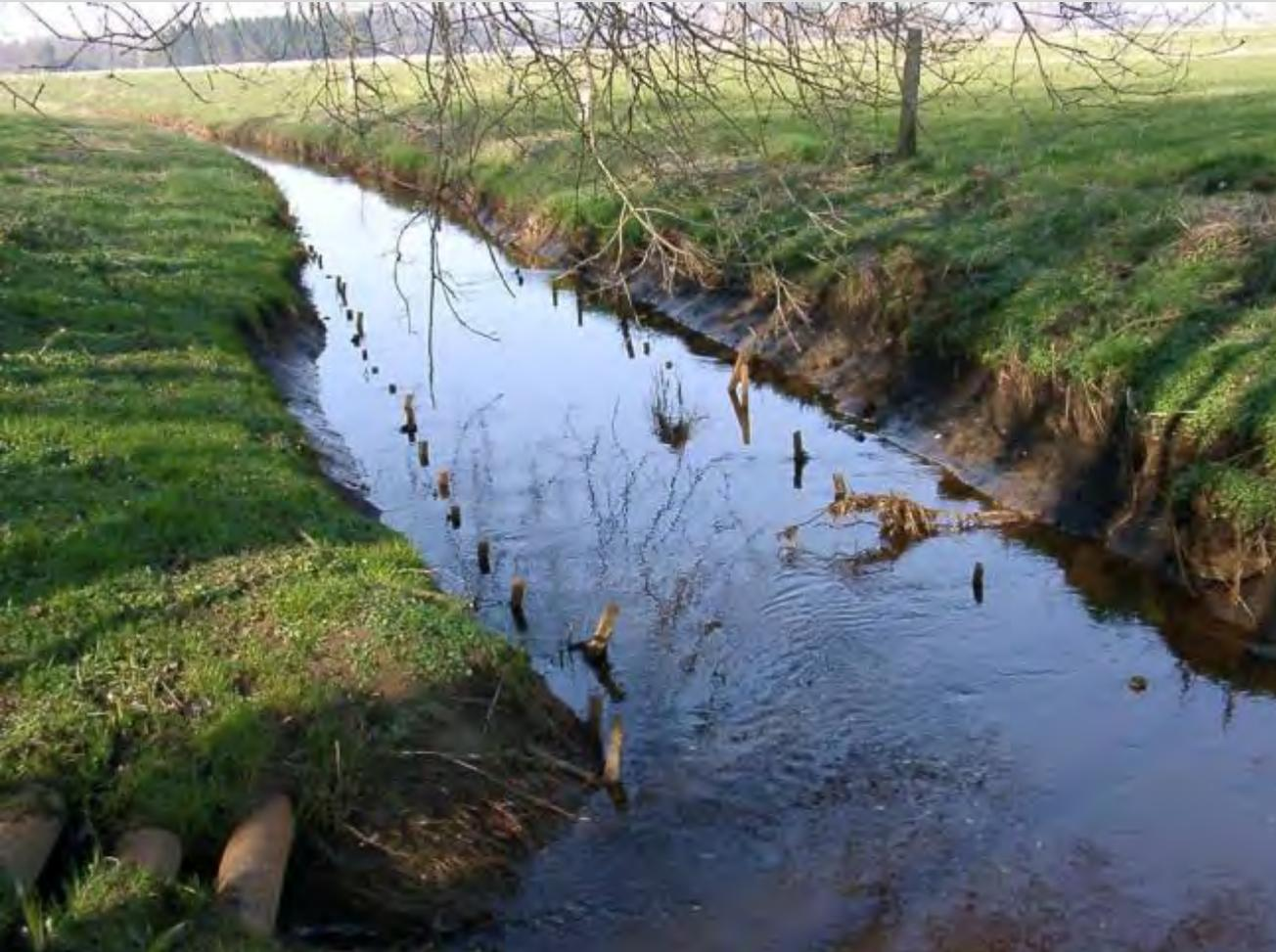
Der Kuhbach im LK Diepholz ist ebenfalls kein organischer Tieflandbach mehr. Er ist zwar weniger tief eingeschnitten, dafür sieht man immer noch die Reste der Verschalung mit dem Tropenholz Bongossi aus den 1960er Jahren. Die Geländemorphologie würde eine Beweidung ermöglichen.
